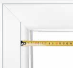
Doporučený bod pro měření: Spára zasklívací lišty příp. dbejte na kování
